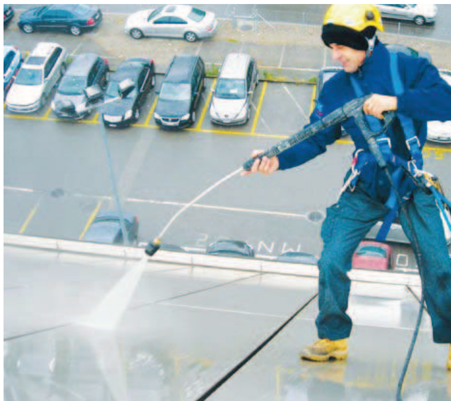
Fassadenreinigung mit eigenen Industriekletterern
