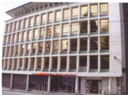
Nach der umfassenden Reinigung und Neubeschichtung erscheint es wieder im ursprünglichen Aussehen.
