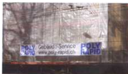
Das Gebäude wurde während der Facharbeiten mit einer Schutzfolie eingehüllt.
